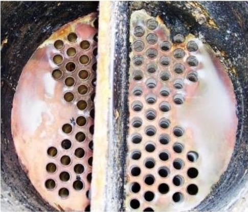
清洗后：白色水垢去除，铜管没有腐蚀痕迹
